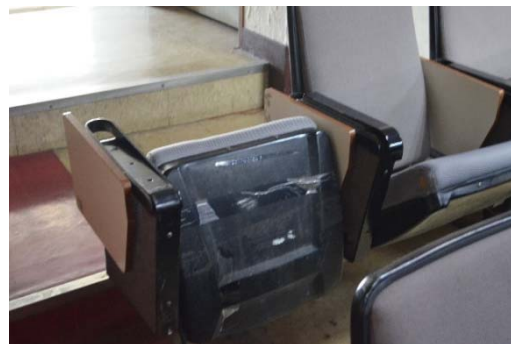
座椅損毀。地科院提供
